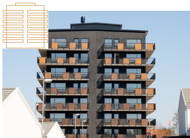
Konstruktionsfakta: Konstruktion helt i betong med sandwichytterväggar, homogena lägenhetsskiljande väggar samt bjälklag.
